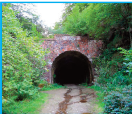
Túnel de La Engaña
