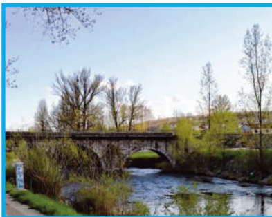
Puente sobre el Carrión
